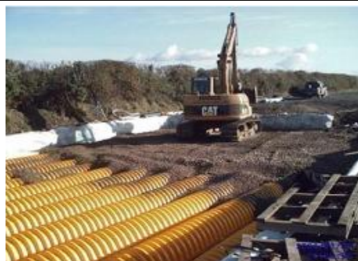
8. Warstwa tłucznia zgodna z projektem, minimum 15 cm
