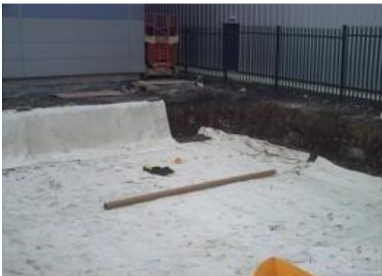
1. Wykonujemy wykop, następnie wykładamy wykop geowłókniną
