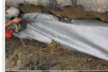
◀ Fot. 5. Zamknięcie drenażu za pomocą np. metalowych szpilek typu U
