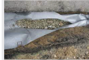
◀ Fot. 4. Wypełnienie wykopu kruszywem odpowiedniej frakcji (16/63 mm)
