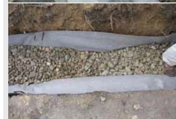
◀ Fot. 3. Wyłożenie wykonanego wykopu odpowiednio dobraną geowłókniną igłowaną
