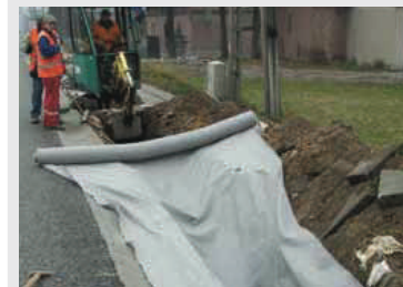
◀ Fot. 2. Wykonanie wykopu wąskoprzestrzennego o szerokości równej szerokości projektowanego drenażu
