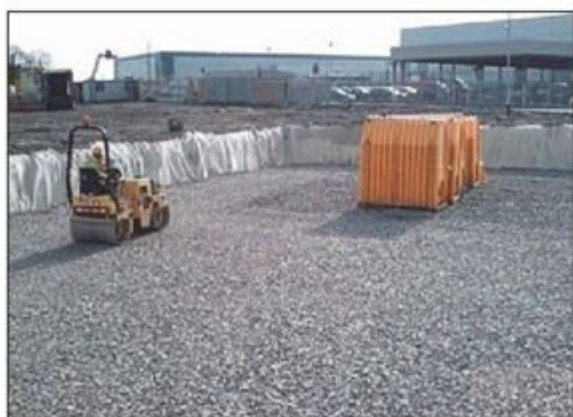
3. Tłuczeń zgęszczamy do min. 95% gęstości standardowej Proctora
