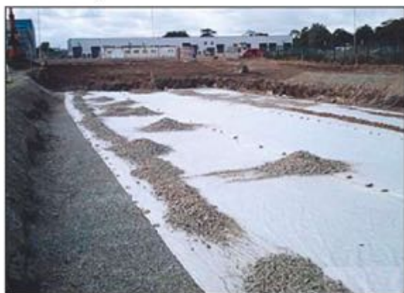
7. Układamy geowłókniną, a nad nią wykonujemy zasypkę, którą zagęszczamy co 15 cm
