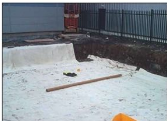
1. Wykonujemy wykop, a następnie wykładamy wykop geowłókniną
