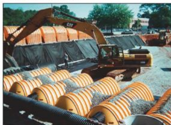
6. Przykrycie systemu wykonujemy za pomocą obsypki z tłucznią
