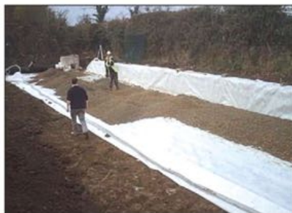
2. Na dnie umieszczamy warstwę minimum 23 cm obsypki z tłucznią (uziarnienie 20÷50 mm)
