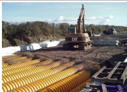
8. Warstwa tłucznia zgodna z projektem, minimum 15 cm
