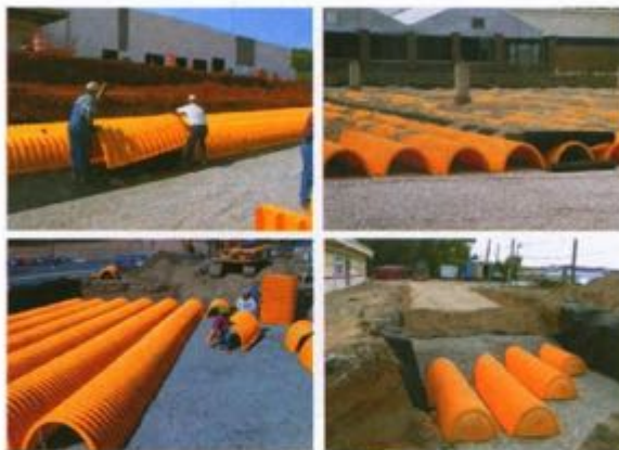
Fot. 8. Montaż systemu komór drenazowych 1)
