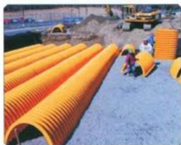
Fot. 3. Montaż systemu komór drenażowych SC.
