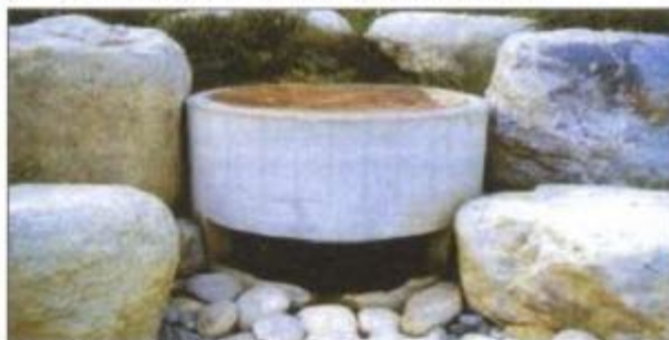
Fot. 1 Betonowa studnia chłonna
