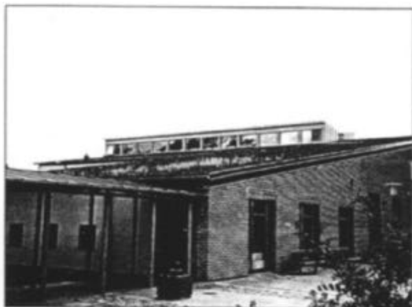
Rys. 1 Biblioteka w Eksjö (Szwecja) jako przykład dużej budowli o dachu spawalniącym spływ wód opadowych (stadium pierwszych nasadzeń)
