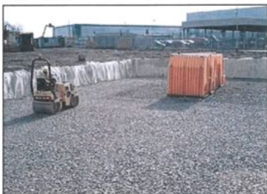
3. Tłuczeń zgęszczamy do min. 95% gęstości standardowej Proctora
