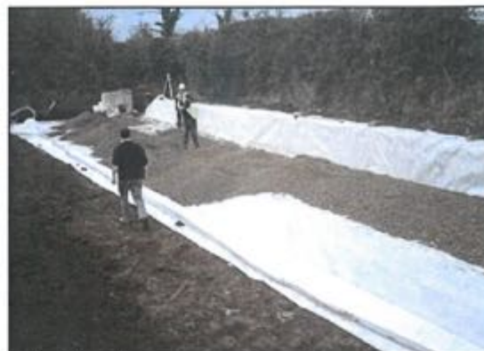
2. Na dnie umieszczamy warstwę minimum 23 cm obsypki z tłuczni (uziarnienie 3/1-6/3 mm)
