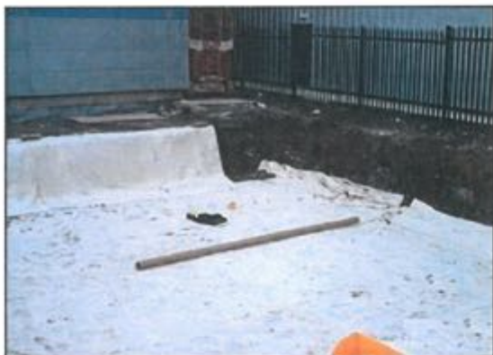
1. Wykonujemy wykop, a następnie wykładamy wykop geowłókniną
