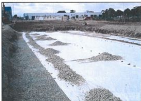
7. Układamy geowłókniną, a nad nią wykonujemy zasypkę, którą zagęszczamy co 15 cm
