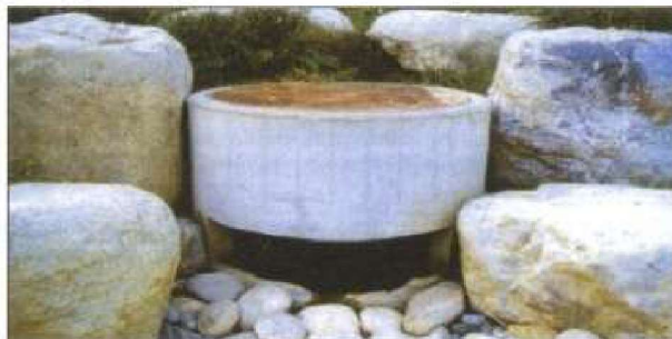
Fot. 1 Betonowa studnia chłonna
